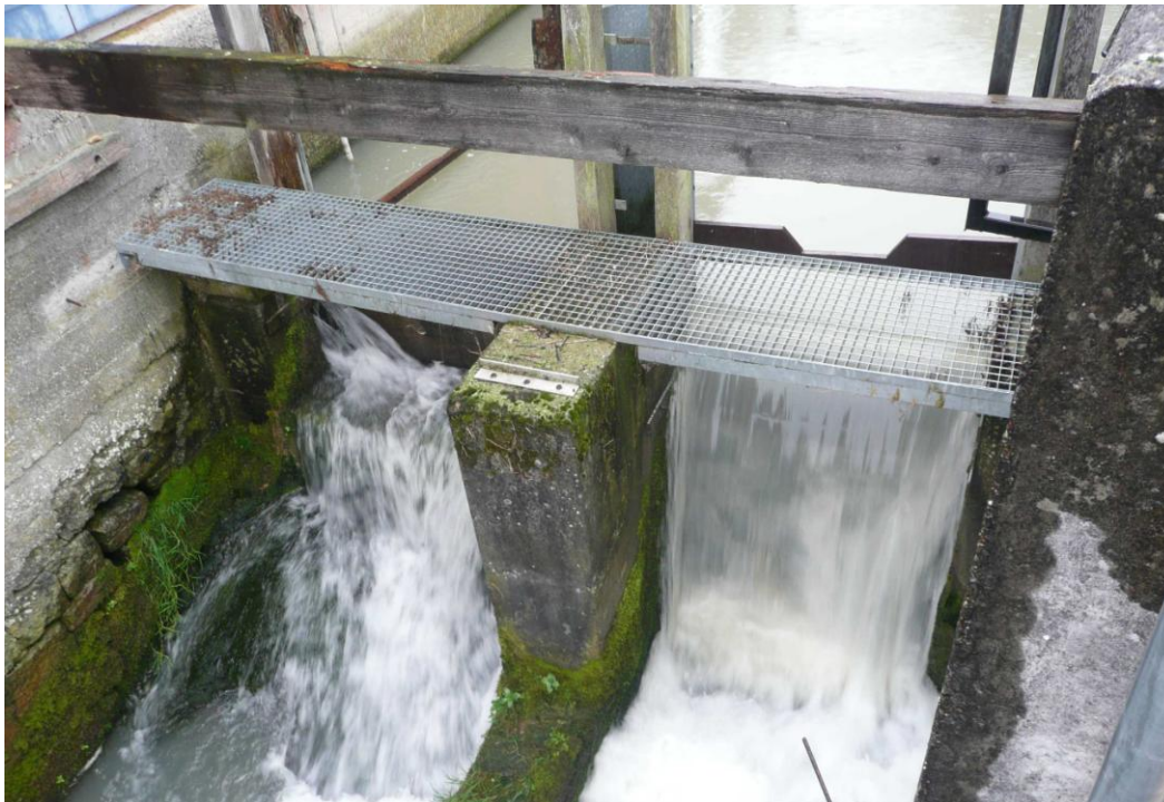
Abbildung 2: Bestehende Wehranlage am geplanten Kraftwerksstandort
