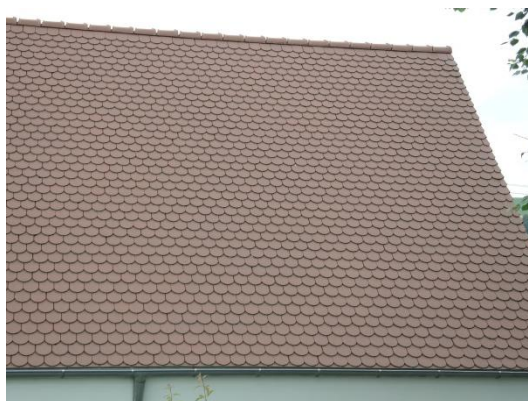
Biberschwanzdoppeldeckung, nicht engobiert
