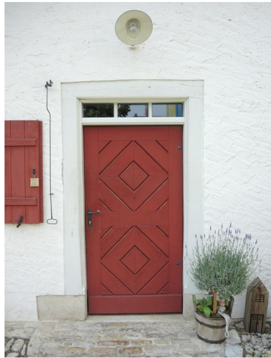
Restaurierte und ergänzt Außentüre an einem Jurahaus
