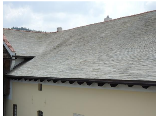
Neues Kalkplattendach mit Kehldeckung
