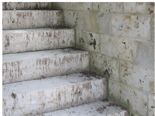
Natursteinaußentreppe und Sockelwandverkleidung
