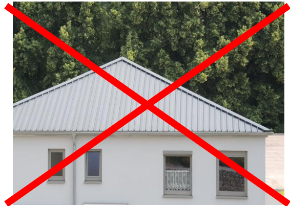
Dach aus Trapezblechen
