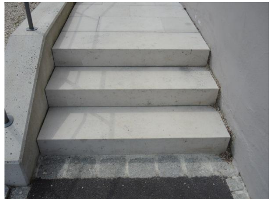
Kalksteinstufen und Gehbelag
