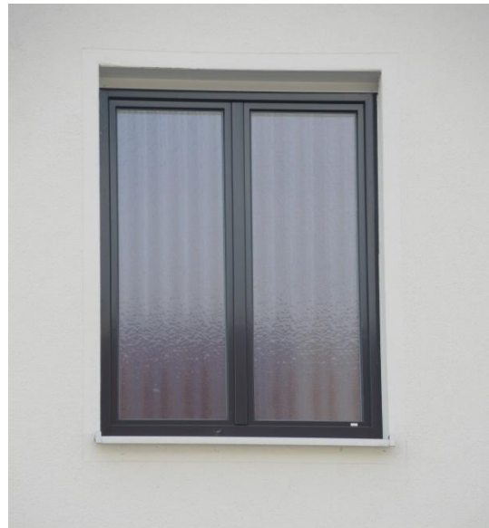
2-flügeliges Fenster mit unifarbener Alu-Oberfläche
