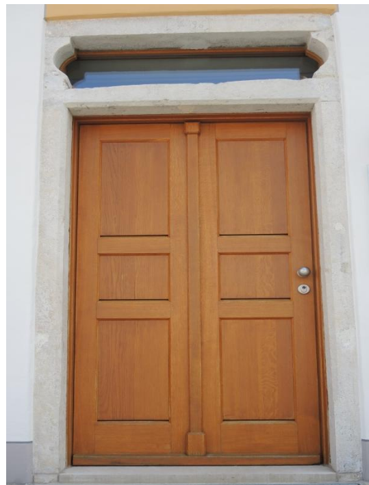
Neues Türblatt in bestehendem Gewände
